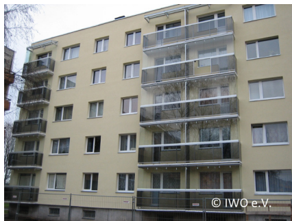
Рис. 5: Комплексная реконструкция панельного здания в Таллине (Эстония)
